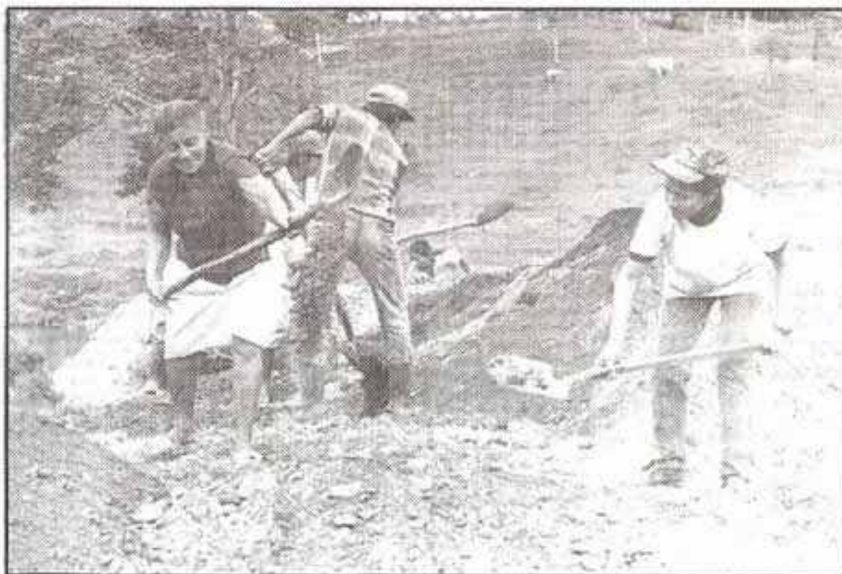
Mujeres del Barrio "Las Viudas" sacando arena del río para construir el Centro Infantil del barrio.
